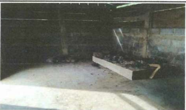
Foto 5: El piso de torta de concreto de la cocina se encuentran en mal estado que requiere de sustitución.
